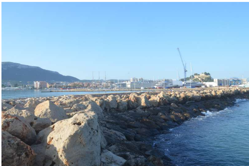
A.M.G. 003. Fotografia general sud de la casamata l'Escullera Nord.
