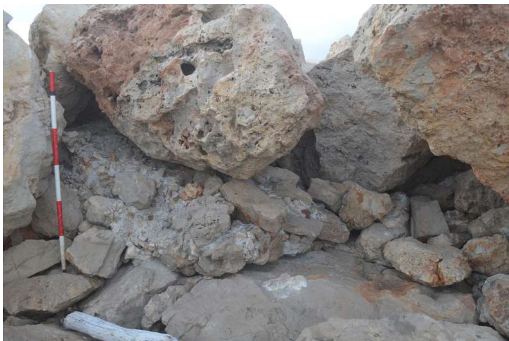
A.M.G. 005. Estructura 001 de la casamata l'Escullera Nord.
